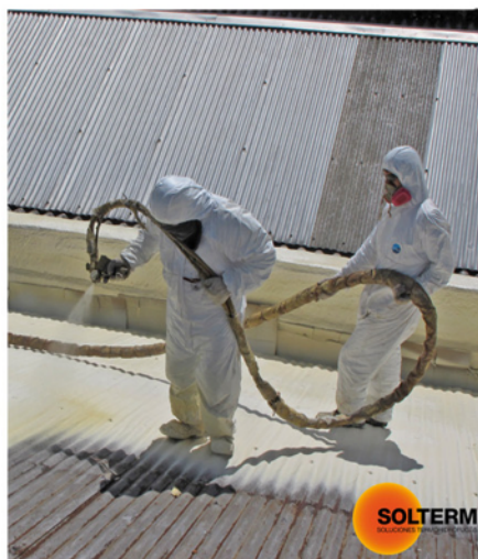
Aplicación de PUR en cubierta metálica con el sistema SOLTERM.
