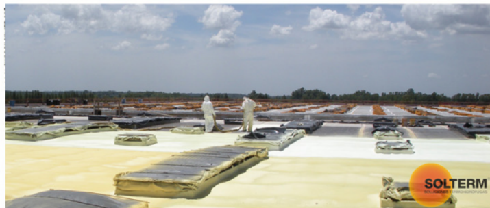
Aplicación de PUR en cubierta plana con el sistema SOLTERM.
